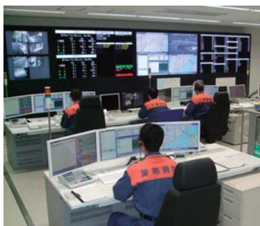
下関市・美祢市消防指令センター
