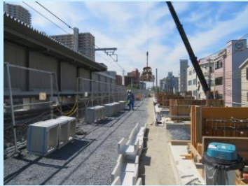
駅舎の解体、新設
