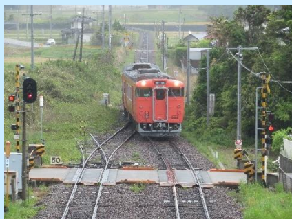
単線区間の行き違い設備
