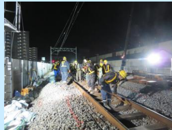
線路の配線変更
