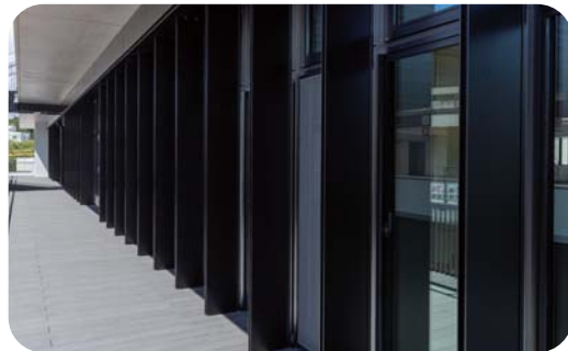
▼ 2階屋外デッキ
