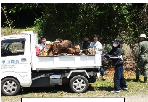
伐採木撤去作業
