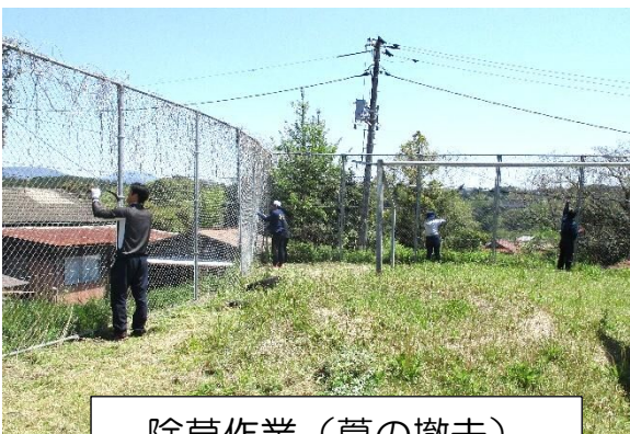
除草作業（蔦の撤去）
