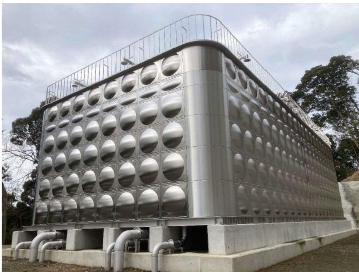
上水道第4配水池
