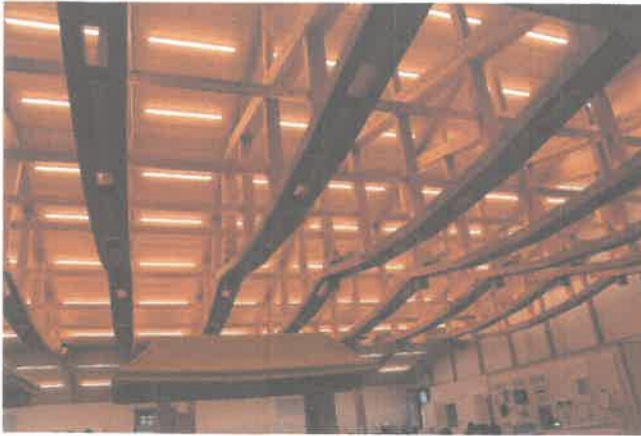
役場庁舎の天井構造（木造建築費 23 億（補助なし？） 村内生産木使用量 95%）
