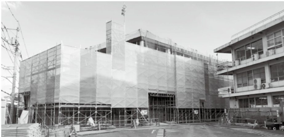
建設中の新本庁舎
