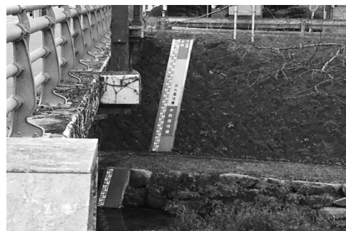
厚狭川に設置されている水位計
