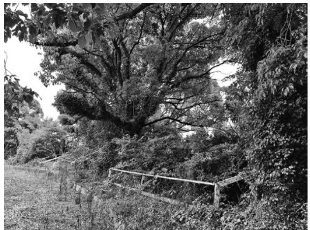
公園内が雑草や雑木で覆われている様子 (伊佐公園グラウンド)
