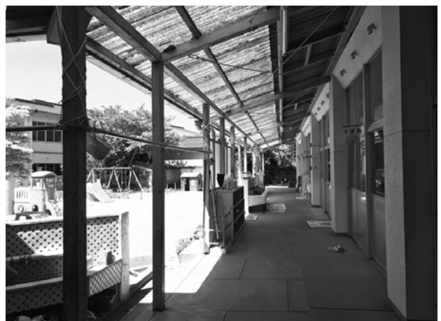
老朽化した園舎(大田保育園)
