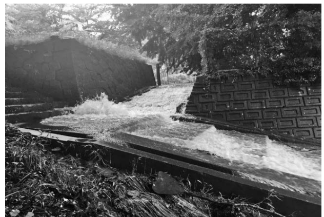
大量の雨水が階段を通じて滝のように流れている姿 (平成30年7月6日伊佐公園グラウンド)
