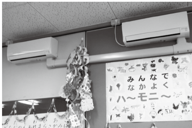
小学校に設置された家庭用エアコン(綾木小学校)
