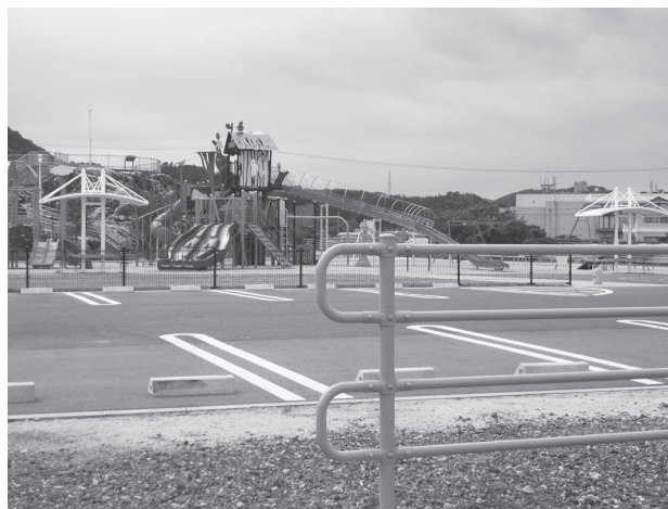
このたび美祢さくら公園「遊びの広場」駐車場外周に転落防止等の安全対策のため設置された柵
