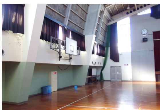
体育館平土間部分。雨漏りが原因となり、壁面(写真カーテン下部分)の塗装が部分的に剥離している。
