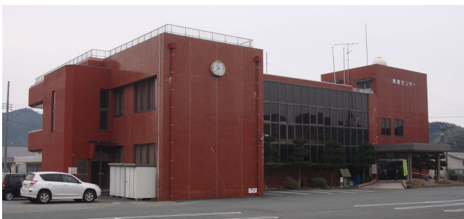
既存の美東センター（大田公民館、美東図書館）
