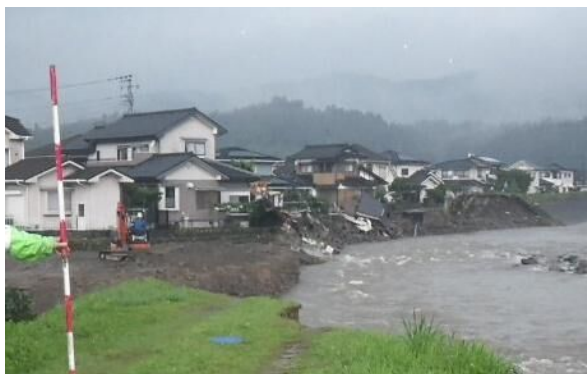
河岸侵食による家屋の倒壊(花月川)
