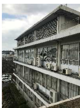
老朽化した外観
