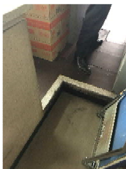
執務室にみられる段差
