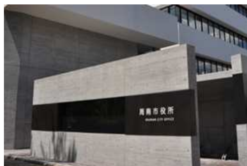
杉板コンクリート型枠を用いた例（周南市庁舎）
