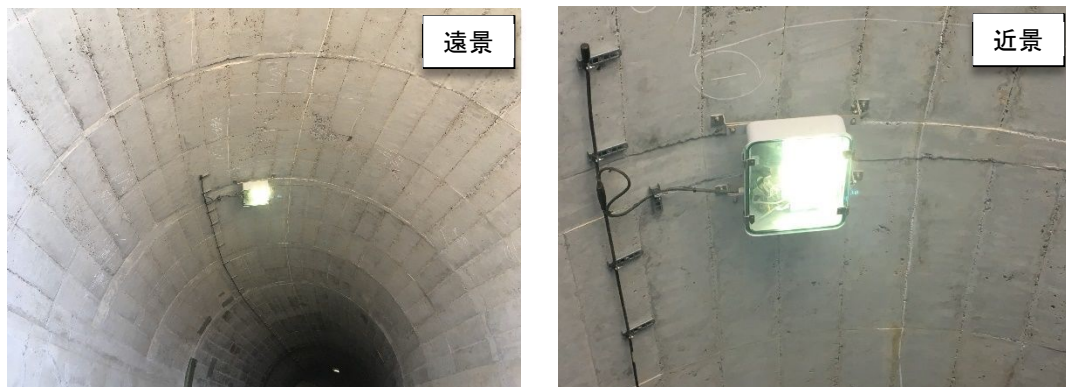
写真 2-1 照明施設(秋吉台隧道)
