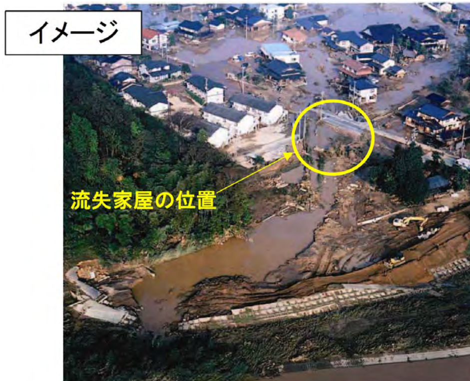
堤防決壊に伴い木造家屋が倒壊した状況
