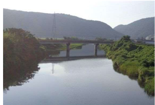
美祢市の管理する橋梁の中で最長（原田橋 PC-T桁橋 橋長86.3m 1972年完成）
