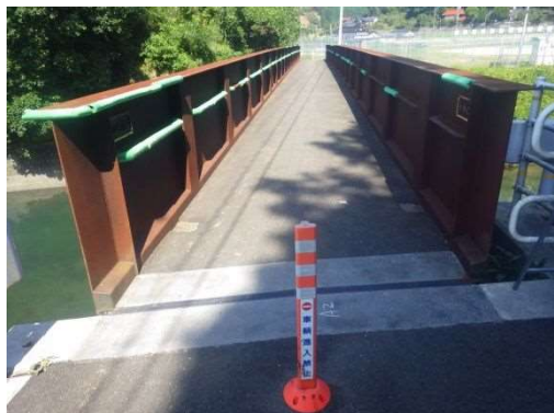
美祢市の管理する橋梁 鋼橋（亀橋 鋼I桁橋 橋長32.1m 2012年完成）
