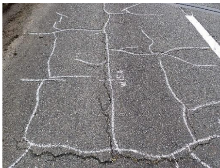
写真2-4 上部工その他(舗装、地覆・高欄)の損傷状況
