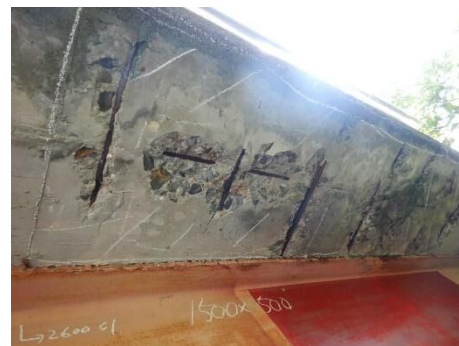
写真2-6 上部鋼(Con床版)の損傷状況
