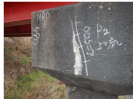
写真2-7 上部工その他(舗装)、下部工(橋台・橋脚)の損傷状況
