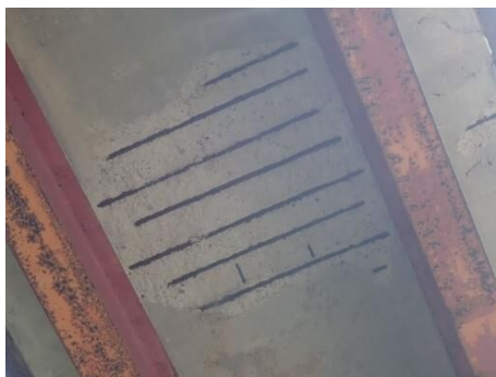
写真2-6 上部鋼(Con床版)の損傷状況
