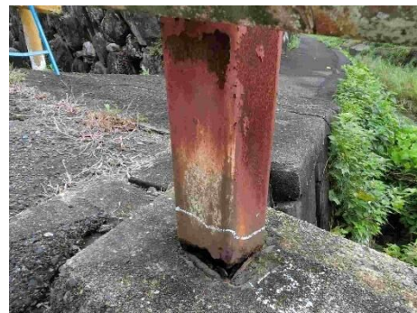
写真2-4 上部工その他(舗装、地覆・高欄)の損傷状況
