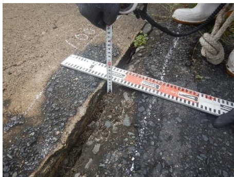
写真2-7 上部工その他(舗装)、下部工(橋台・橋脚)の損傷状況
