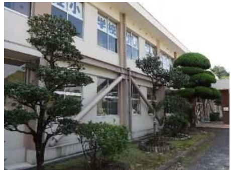
耐震改修を行った伊佐小学校
