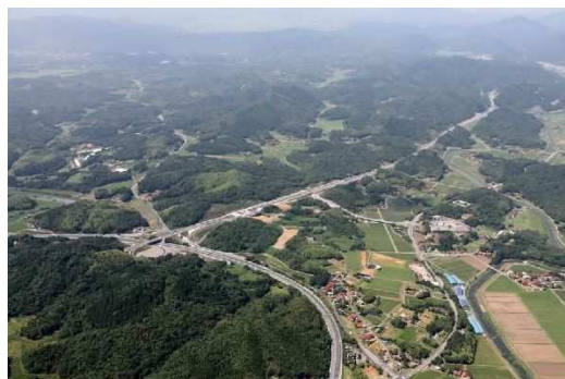
地域高規格道路小郡萩道路と中国縦貫自動車道
