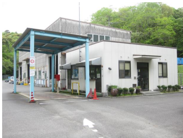
管理棟・計量器
