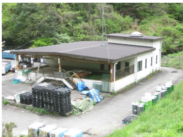
浸出水処理施設
