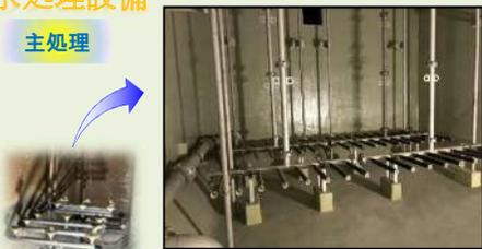
◎主処理では、微生物の力で有機物を分解し、汚濁物質を減少させます。
