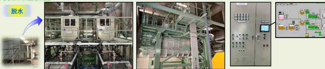
◎汚泥処理では、水処理で活躍した微生物群および高度処理で沈殿・除去した微細粒子を汚泥水（含水率99%以上）として集め、固形物として搬出可能な水分量（含水率83%以下）まで脱水します。
