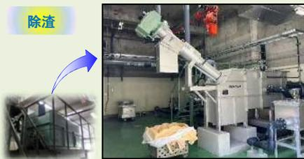
◎貯留したし尿・浄化槽は、初めに粗大なゴミを取り除くためにスクリーンに投入します。
