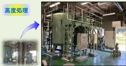
◎高度処理では、主処理で除去できなかった汚濁物に凝集剤を注入して沈殿除去し、仕上げとして色度を除去します。
