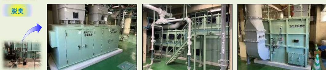
◎し尿処理施設では、有機物が微生物によって分解される過程で、アンモニアや硫化水素などの臭気物質が発生することから、周辺環境への影響を最小限にするため脱臭設備を設け、臭気成分を除去して大気開放します。
