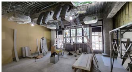
▲1階会議室の工事風景
