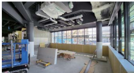
▲市民室の工事風景
