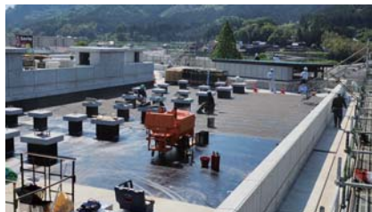
▲屋上の工事風景
