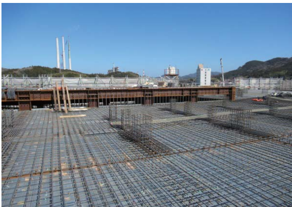
▲屋上の配筋状況
