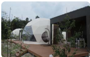
県内初ドーム型グランピング施設
