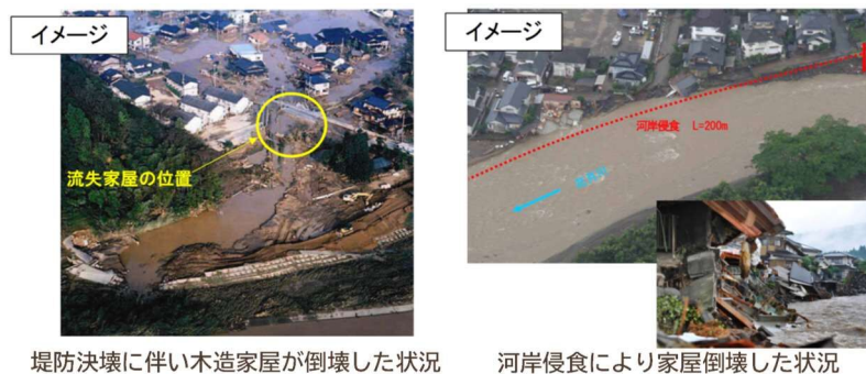
堤防決壊に伴い木造家屋が倒壊した状況
